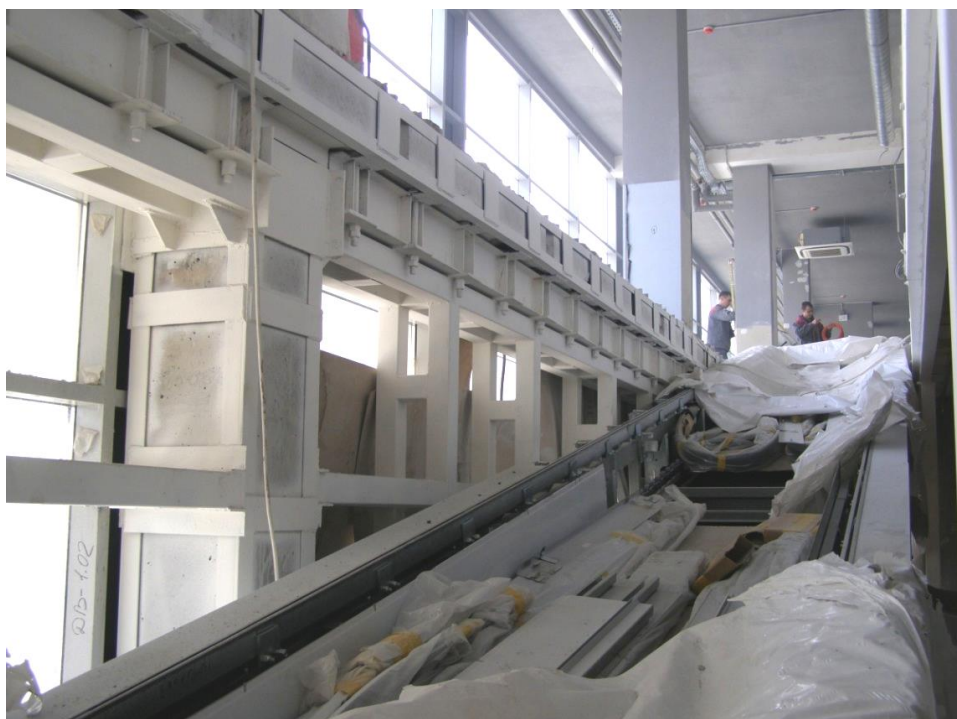
Рис. 3. Усиление конструкций перекрытия над первым этажом в осях А-Б в месте устройства проема под травелатор (в ходе строительства)
