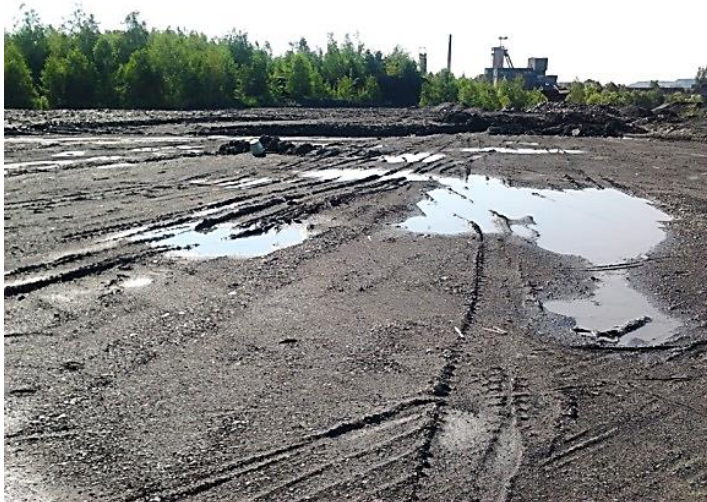
Рисунок 3.3 – Підготовлений до рекультивації породний відвал шахти «Межирічанська» (м. Червоноград) – однієї із найбільш техногенно небезпечних
