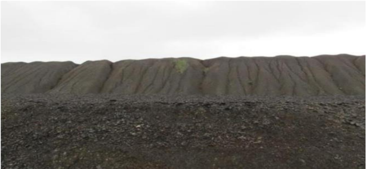
Рисунок 1.1 – Процеси водної ерозії на схилі відвалу на території Нововолинського гірничопромислового регіону (за В.В. Попович)
