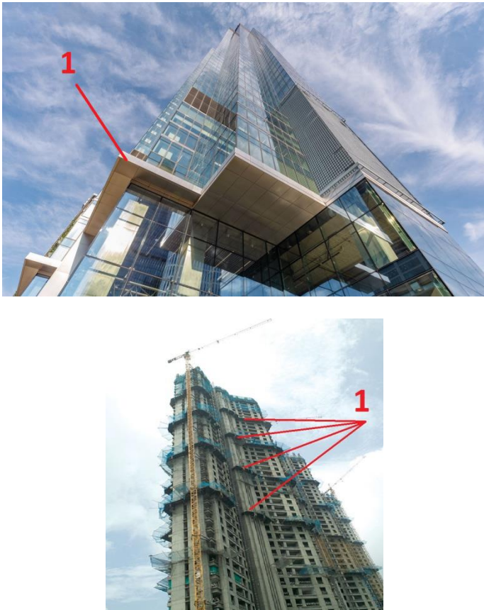
Рисунок 1 – приклад висотних будівель обладнаних протипожежним карнизом (позн. 1)
