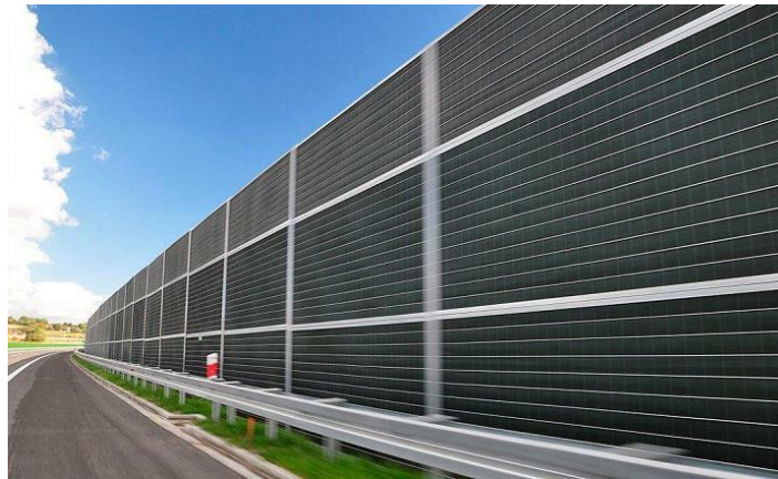
Рис. 3.2. Екрануючі шумозахисні споруди вздовж автомагістралей
