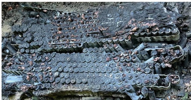
Рисунок 4 – Зовнішній вигляд літій-іонного модуля батареї після проведення експерименту
