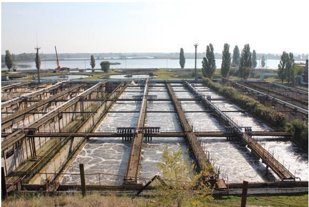
Рис. 3.7. Аеротенки на очисних спорудах м. Львова [23]
