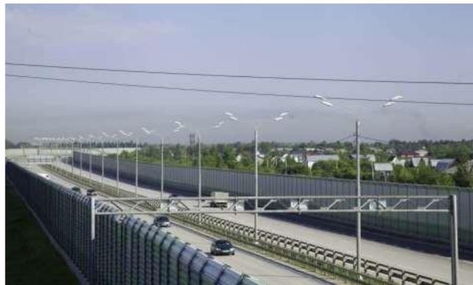
Рис. 4.5 Приклад екрануючих шумозахисних споруд вздовж автомагістралей
