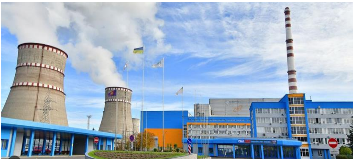
Рисунок 1.4. – Центральний вхід адміністративної будівлі ВП «Рівненська АЕС» [7]
