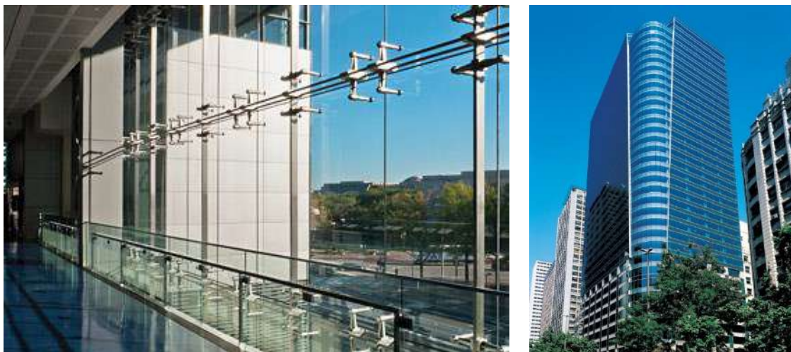
Рисунок 1.6 – Скляні світлопрозорі фасадні системи із суцільним склінням та спайдерним кріпленням [12]
