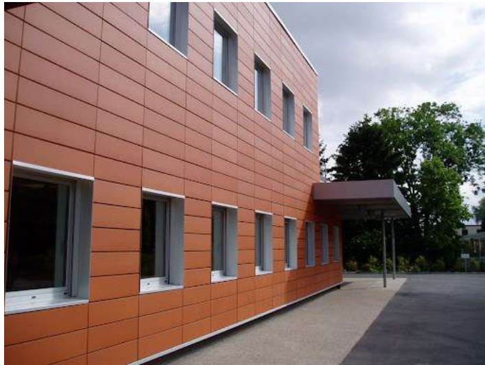
Рисунок 1.2 – Приклад «сухого фасаду» із навісними елементами [12]
