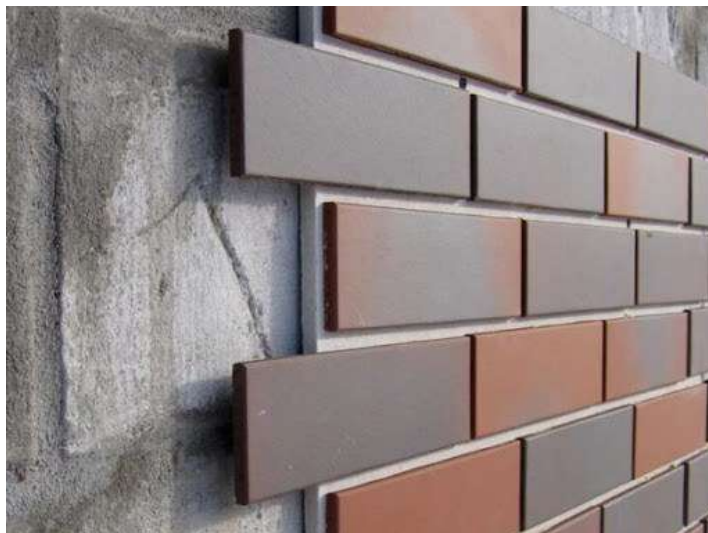
Рисунок 1.4 – Поліфасад із застосуванням керамічної плитки [12]
