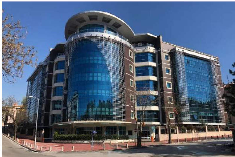
Рисунок 1.7 – Комбінований тип фасадної системи в комбінації «сухого фасаду» та світлопрозорого із скляними модулями [12]
