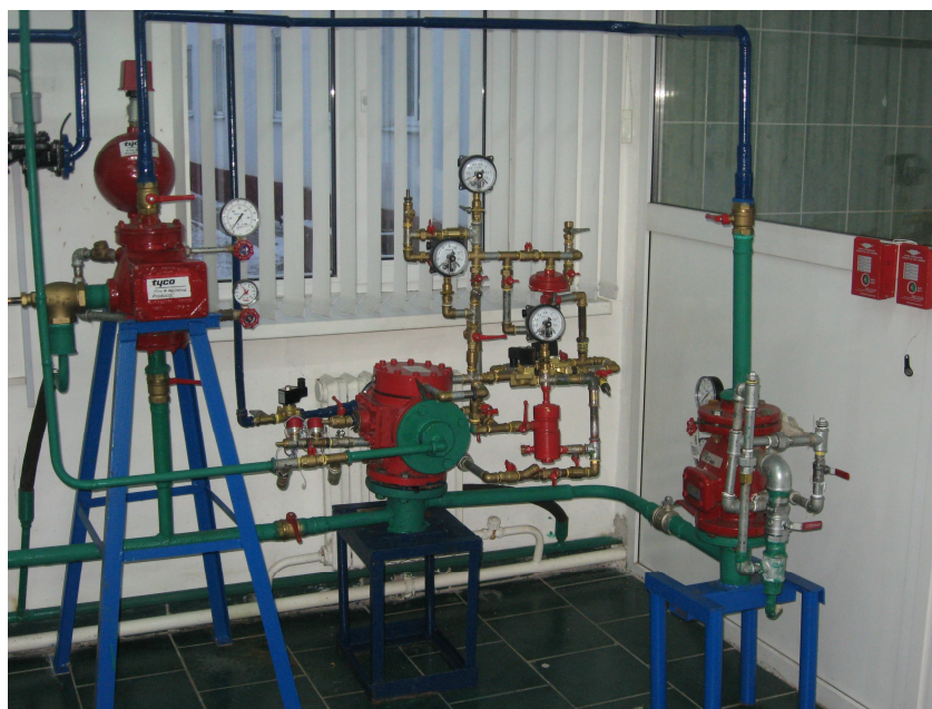
Рис. 2 - Внешний вид узла управления с установленным клапаном пусковым воздушно-вакуумным
