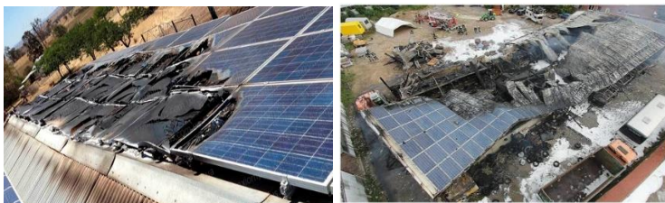
Рисунок 1 – Наслідки загорання на сонячній електростанції
