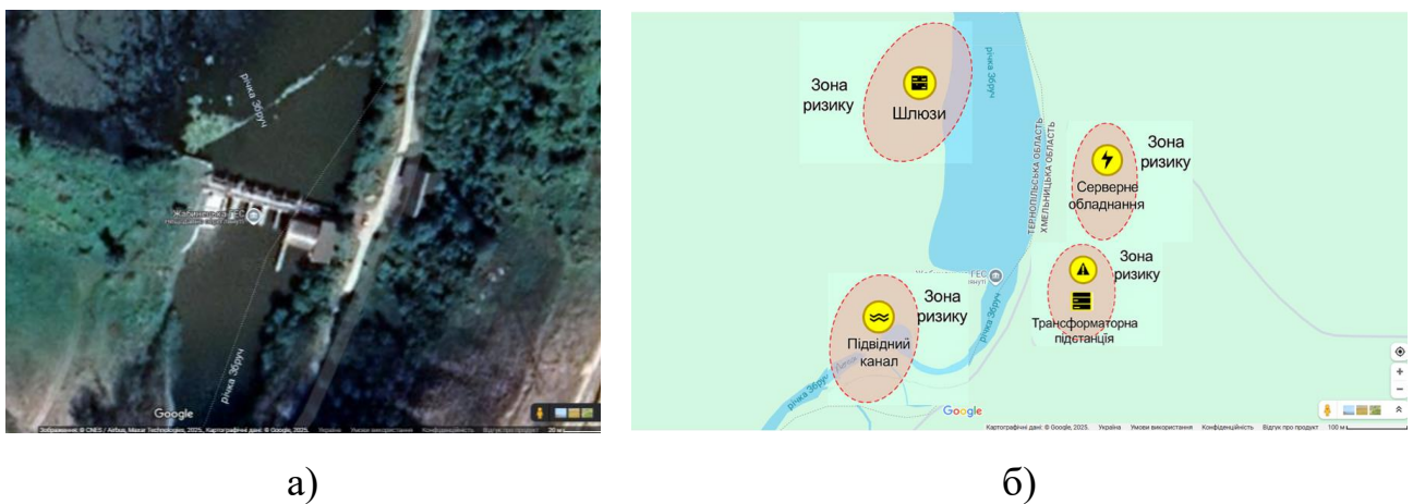
Рисунок 4.10 – Карта просторових зон підвищеної вразливості об'єкта критичної інфраструктури (Жабинецької ГЕС): а) супутникове зображення гідроелектростанції та прилеглої території; б) цифрова карта вразливості із зазначенням критичних точок – шлюзів, трансформаторної підстанції, серверного обладнання та зони підвідних каналів
