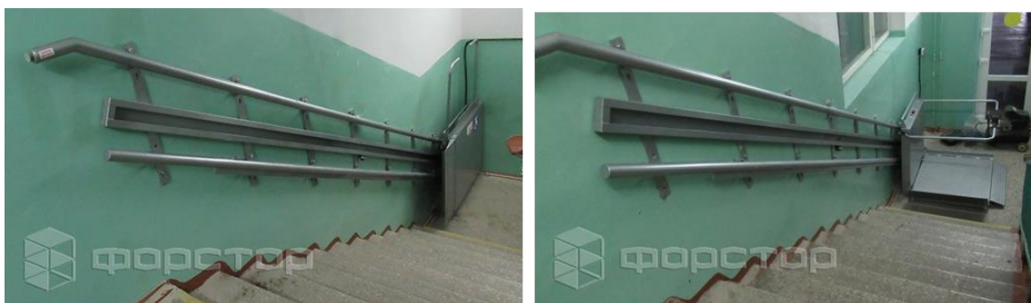
Рис. 3 Встановлення похилого підйомника на шляху евакуації в укритті.
