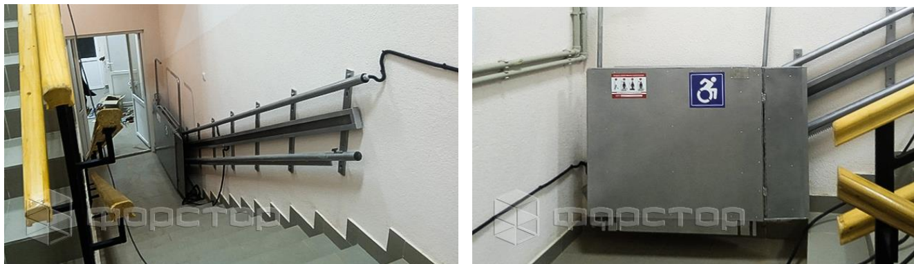
Рис. 1 Встановлення похилого підйомника на шляху евакуації дошкільному навчальному закладі
