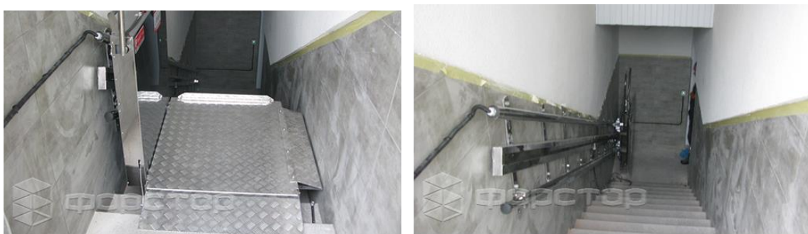
Рис. 3 Встановлення похилого підйомника на шляху евакуації в укритті.
