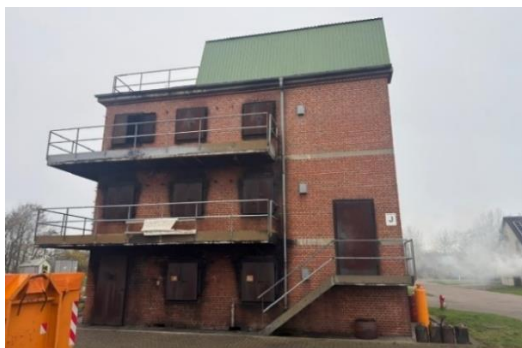
Рисунок 6 – Спеціалізована будівля для практичних відпрацювань у Центрі підготовки пожежників, м. Тінглев, Королівство Данія
