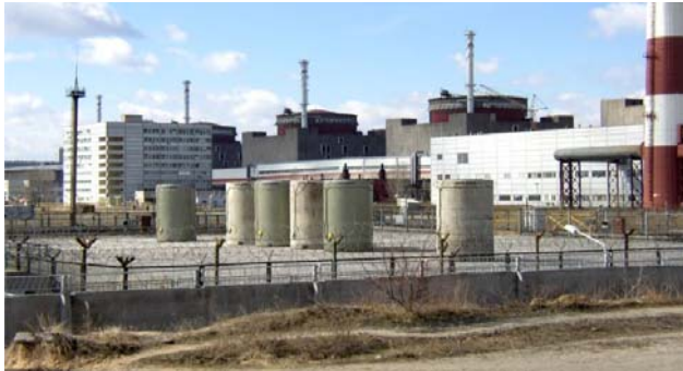
Рис. 1. Перші контейнери на майданчику ССВЯП Запорізької АЕС
