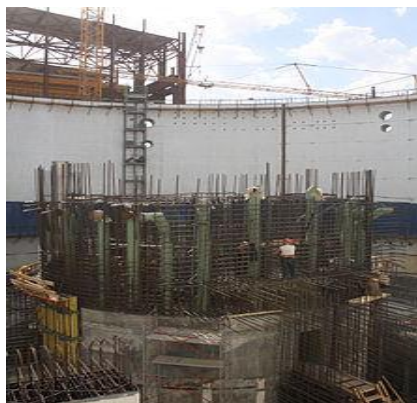
Монтаж ловушки расплава
