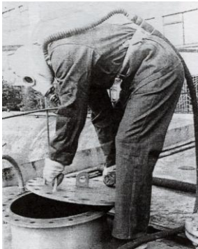
Рис. 6.11. Протигаз ПШ-1
