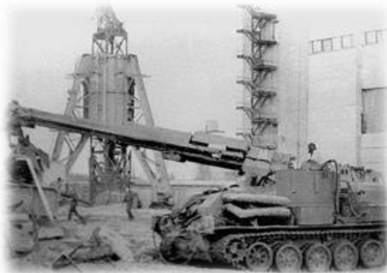
Рис. 4.8. Інженерна машина розгородження ИМР-2 біля зруйнованого енергоблоку ЧАЕС
