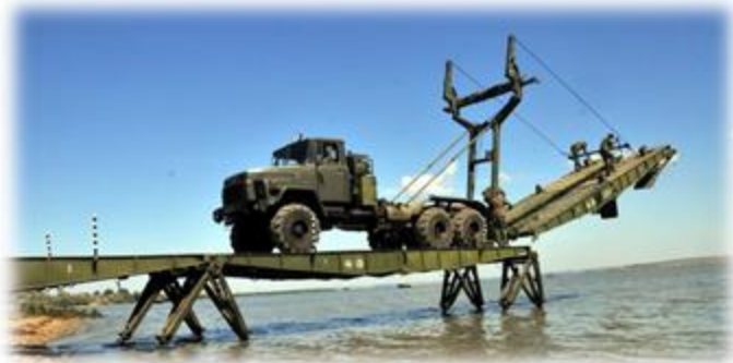
Рис. 1.21. Встановлення секції прогінної будови ТММ-3М1
