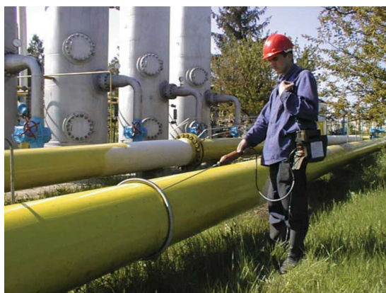
Rys. 1. Badania defektoskopowe elementów rurociągu
