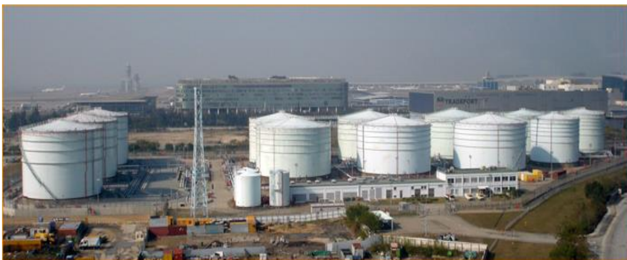
Рисунок 1.6 – Вид на розміщення резервуарів по групах в резервуарному парку
