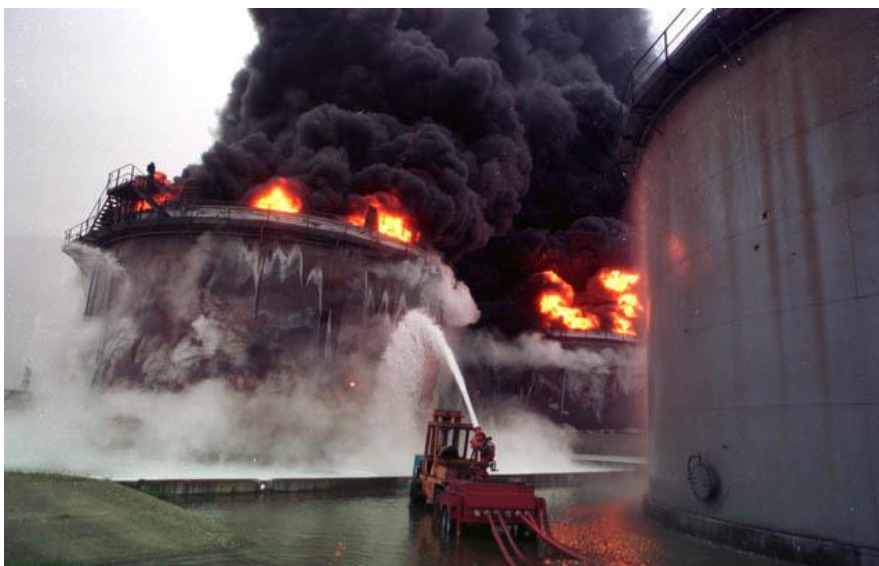
Рисунок 1.8 – Пожежа резервуарного парку
