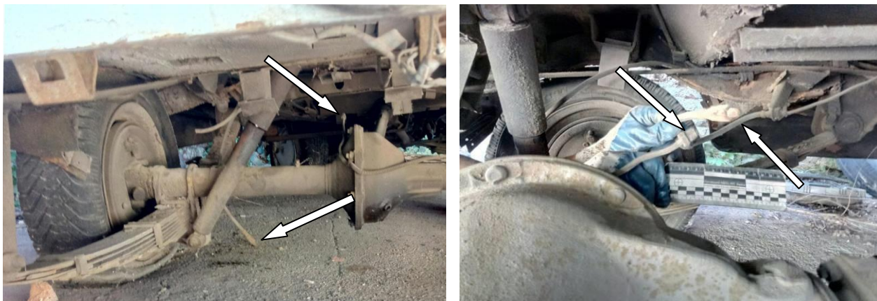
Рисунок 1, 2 – Загальний вигляд пошкодження гальмівного трубопроводу автомобіля РАФ
