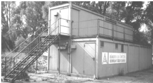
Рис. 2. Загальний вигляд ТДК контейнерного типу
