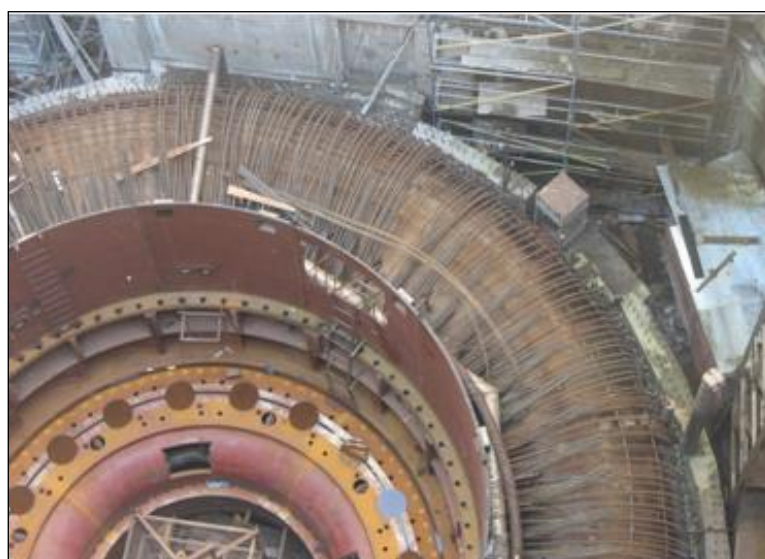
Рис. 2. Фрагмент выполнения монтажных работ при строительстве спирального блока
