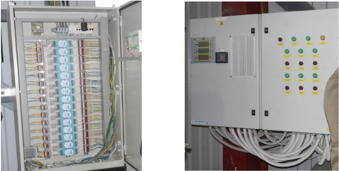
Рис. 2.3 Зовнішній вигляд схеми під'єднання термопар до вимірювально-реєструвального приладу
