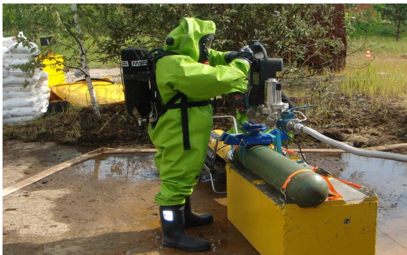
Рисунок 1 - Утилизация аварийных емкостей с хлором
