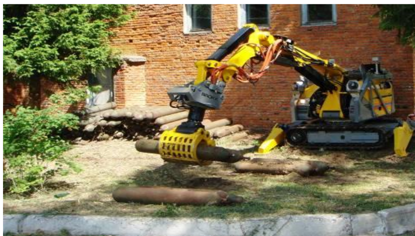
Рисунок 2- Использование робототехнического комплекса BROKK 330 D
