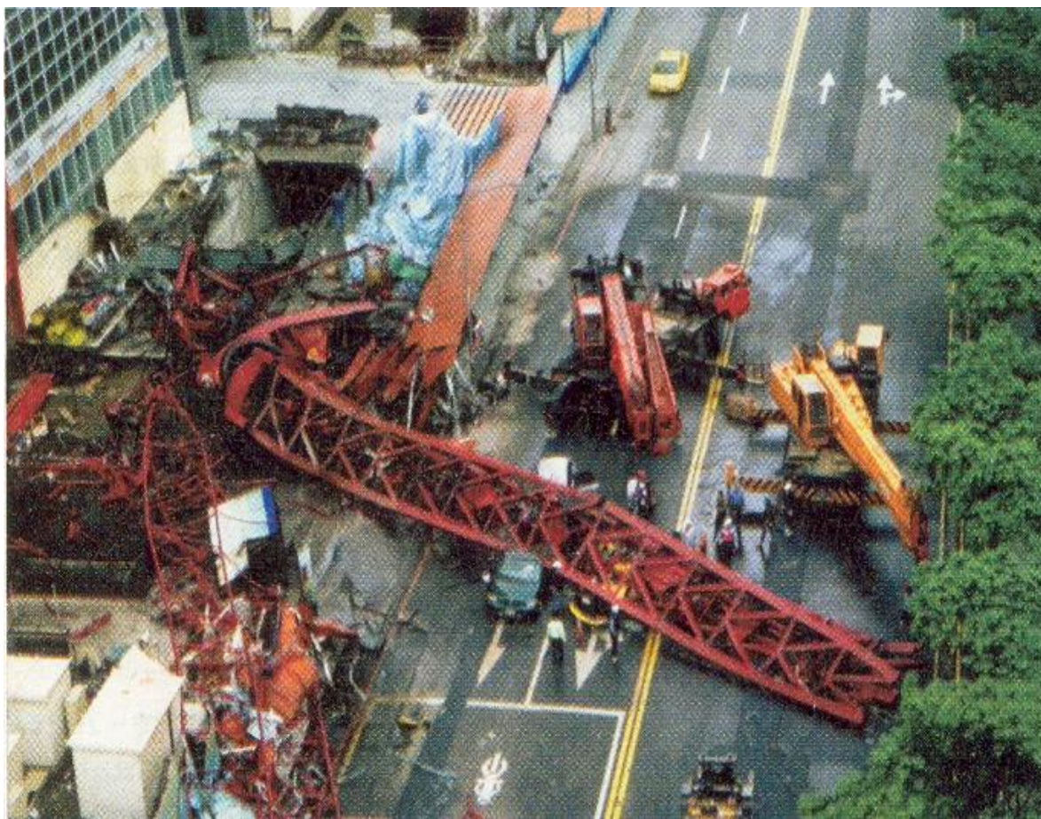
Рисунок 2 - Падение строительного крана на городскую магистраль при монтаже конструкций высотного здания
