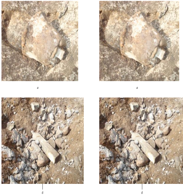
Рисунок 2.1 - Разрушение железобетона взрывом заряда геляпора
