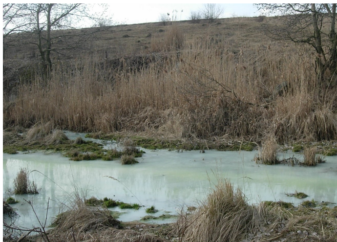
Рис. 3. Витоки сірководневих вод з дренажів східної частини хвостосховища № 1
