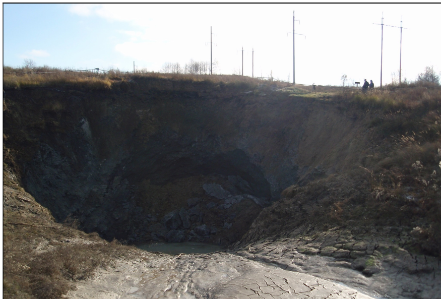
Рис. 5. Провалля над карстом № 20, що розташоване на відстані 90 м від автодороги Львів-Трускавець у листопаді 2009 р.
