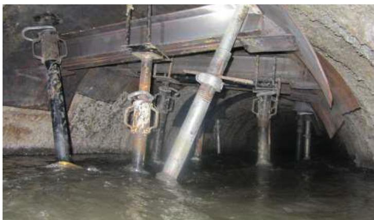
Рис. 7. Фотофиксация вертикального закрепления конструкций канализационного тоннеля
