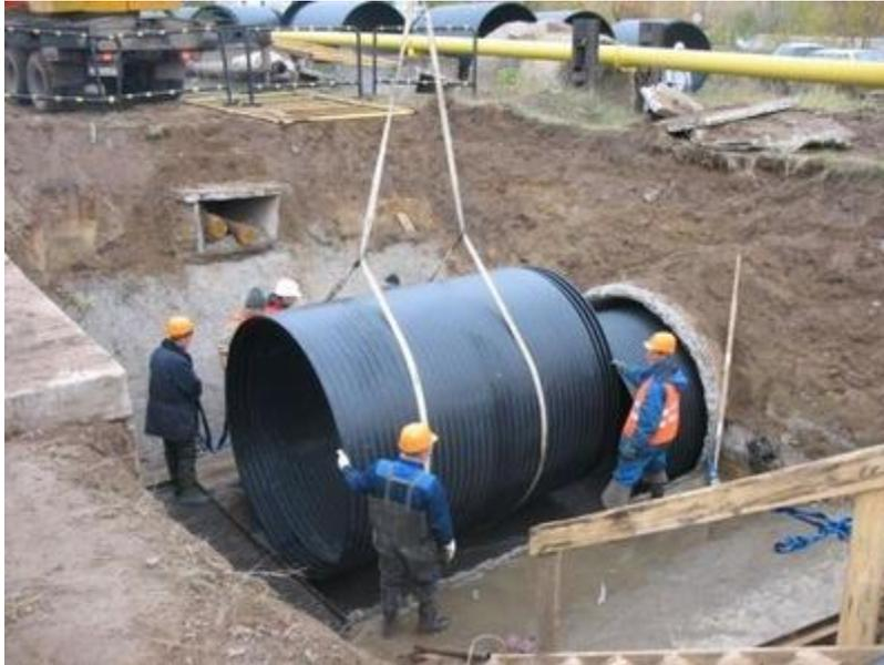
Рис. 1 Подача нарезных элементов трубопроводов
