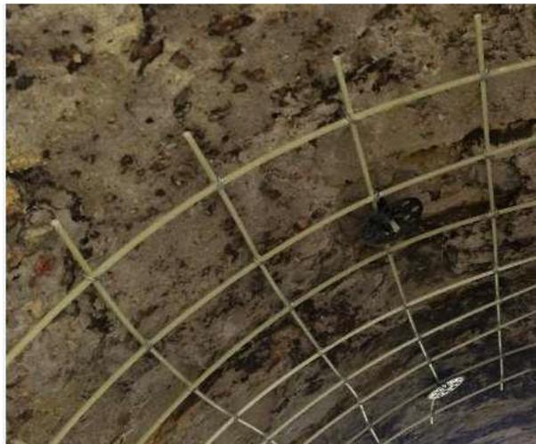
Рис. 11. Армирование стеклопластиковой арматурой сводчатой части коллектора
