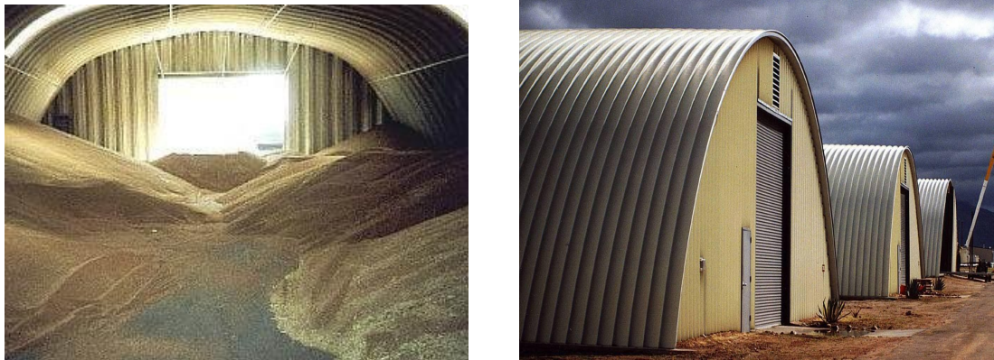
Рис.4.1. Зерносховища горизонтального зберігання на базі безкаркасних арочних будівель з оцинкованої сталі
