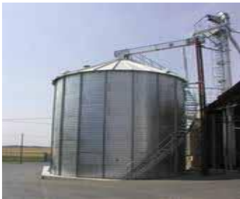
Рис.4.5. Зерносховище баштового типу ємкістю 5000 т
