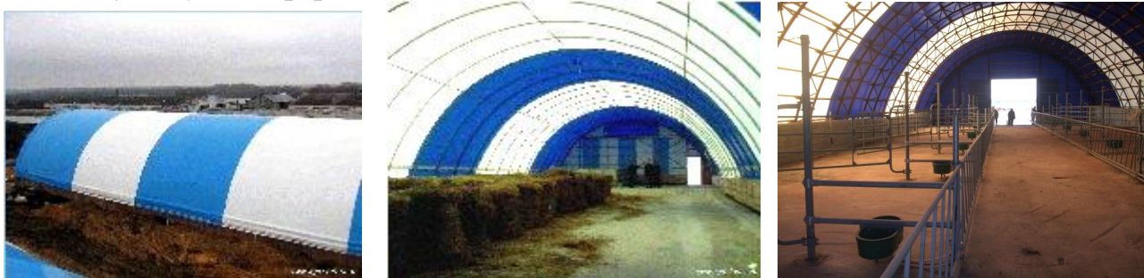
Рис. 6.2. Будівлі корівників арочного типу
